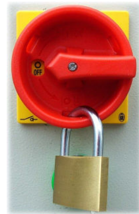
Abb. 58 Hauptschalter gesichert
