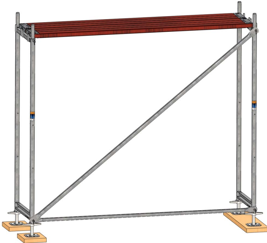
Bild 16: Fertig montiertes erstes Gerüstfeld
