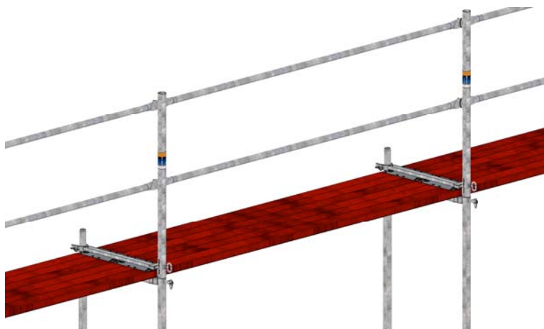
Bild 45: Oberer Abschluss mit Geländerpfosten und Belagsicherungen.
