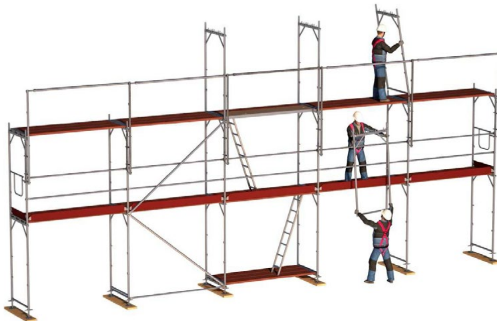
Bild 30: Montage der Gerüstlage im Schutze des MSG.
