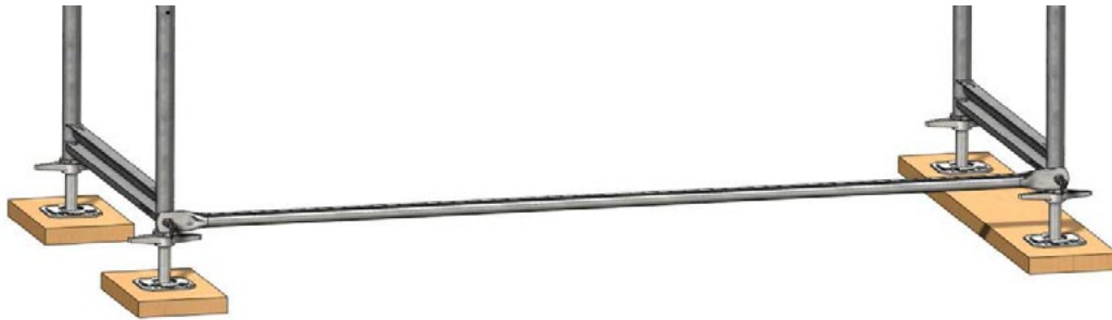
Bild 7: Aufbau des ersten Gerüstfeldes: Längsriegel
