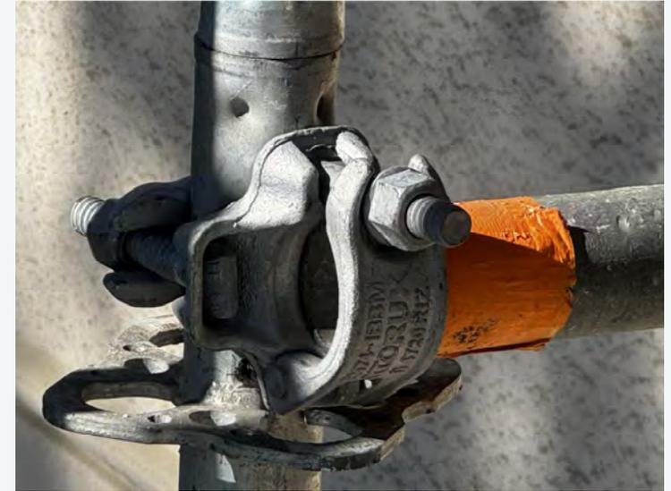
Rohrenden müssen von beiden Kupplungsbacken geklemmt sein
