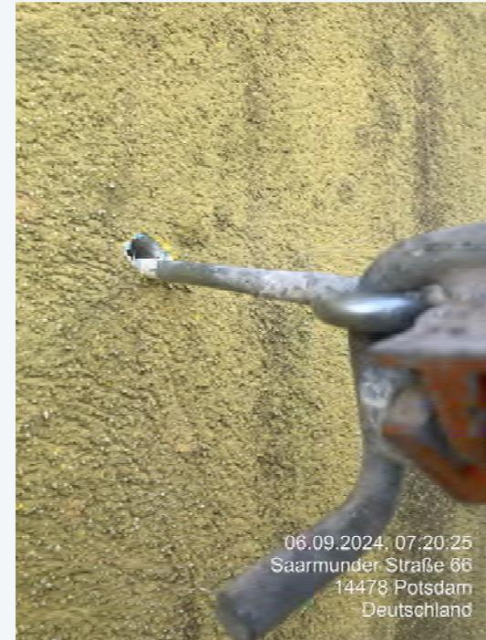
Verankerung nur im WDVS/ Dämmung
